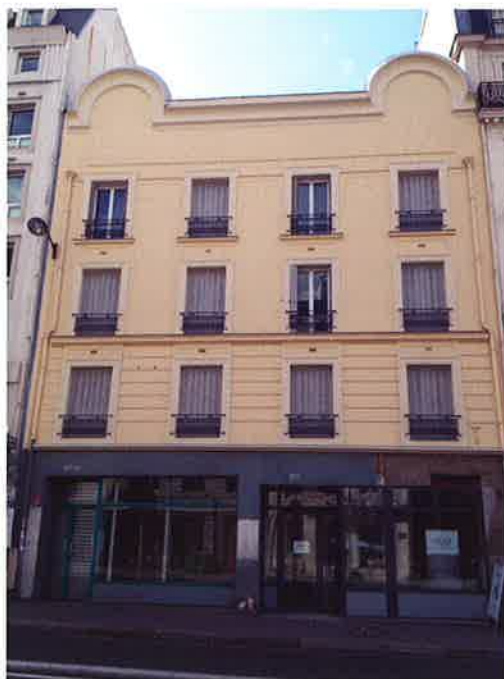
Les nouveaux locaux de HEAD situés au 120, rue Lafayette
